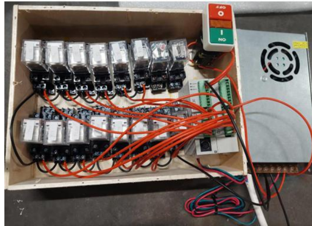
Gambar 5. Pemasangan kabel pada PLC
